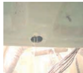
Grzałka tacy skroplin pozwala na utrzymanie drożności otworów odprowadzenia skroplin.
