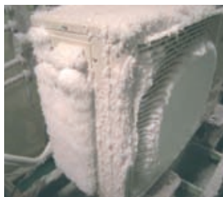
Zaszroniona jednostka zewnętrzna – szron znacznie ogranicza przepływ powietrza przez wymiennik ciepła
