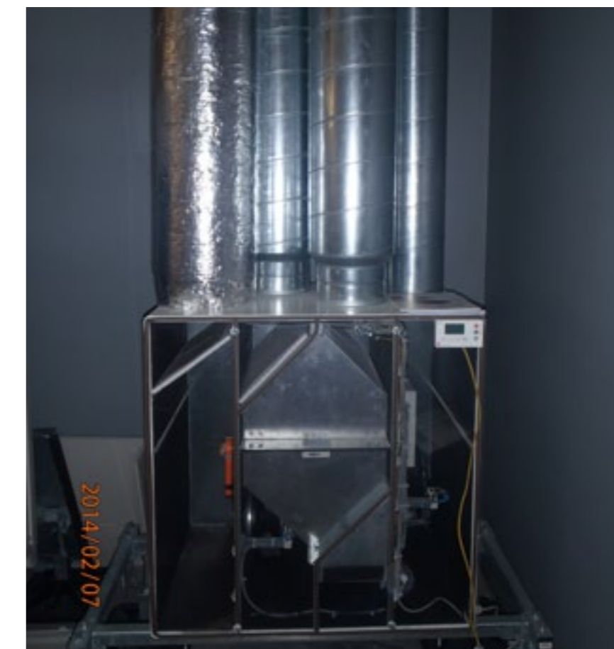
Rekuperator po zdjęciu obudowy, widoczne elementy, jak: wymiennik, filtry, wentylator...
