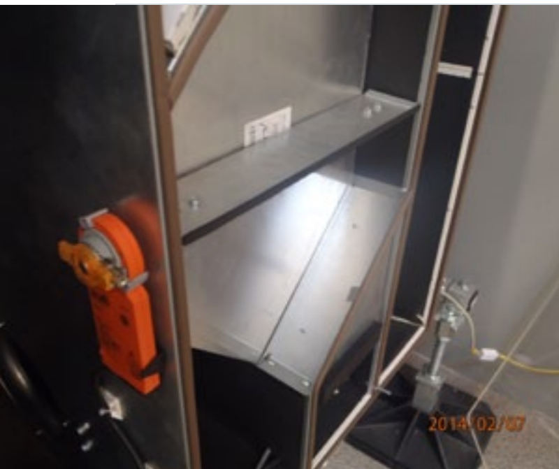
Zastosowanie by-passu to jeden ze sposobów na odszranianie wymiennika
